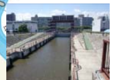
荒川ロックゲート
