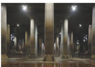
首都圈外排水渠 压力调节槽（埼玉县春日部市）
