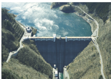
浦山大坝（埼玉县秩父市）
