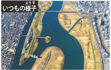
岩淵水門 (北区) のまわり
