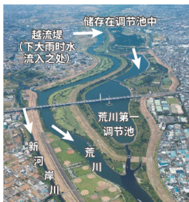
荒川第一调节池（埼玉县埼玉市、户田市）
