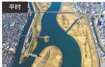
岩渊水闸（北区）附近
