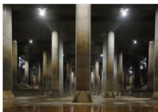
首都圏外郭放水路 調圧水槽 （埼玉県春日部市）
