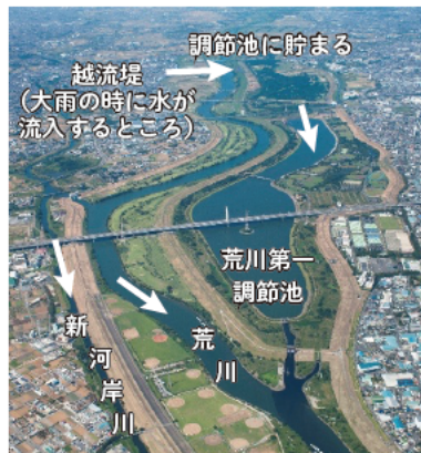
荒川第一調節池 （埼玉県さいたま市、戸田市）
