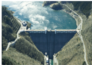
浦山ダム（埼玉県秩父市）
