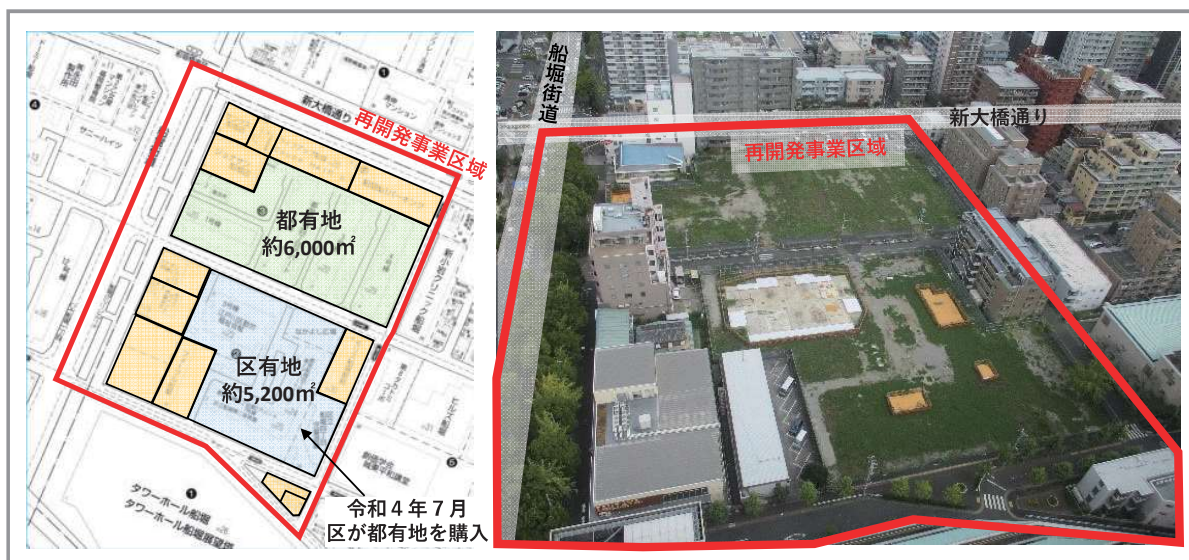
船堀四丁目地区第一種市街地再開発事業区域
