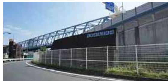
旧葛西海岸堤防
