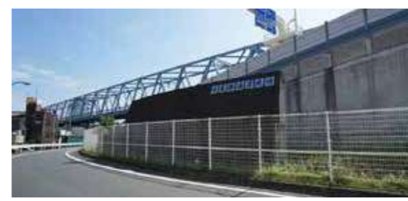
旧葛西海岸堤防
