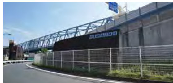
旧葛西海岸堤防
