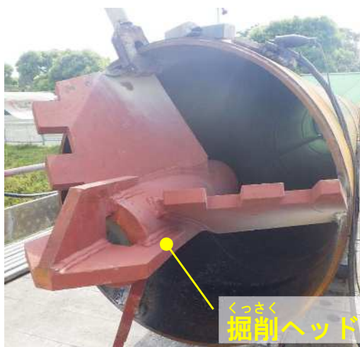
くっさく 掘削ヘッド取付状況
