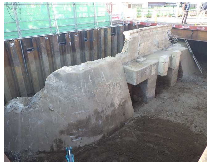
古い橋台 きょうだい
