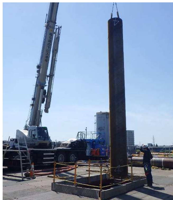
くい たてこみ 杭の建込状況
