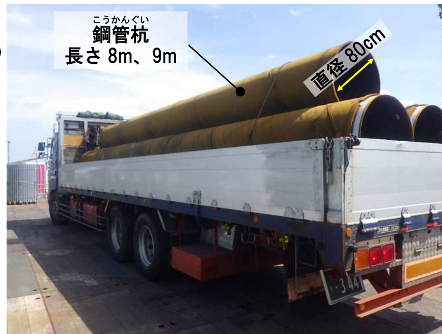
くい 杭の運搬
