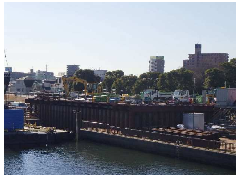
かせつこうだい 完成した仮設構台
