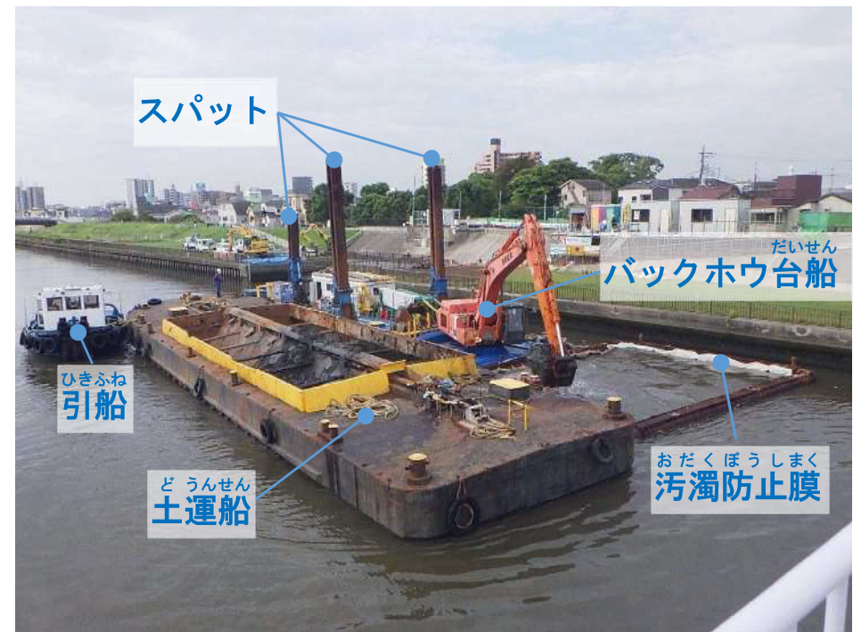
さぎょうせん しゅんせつ作業船
