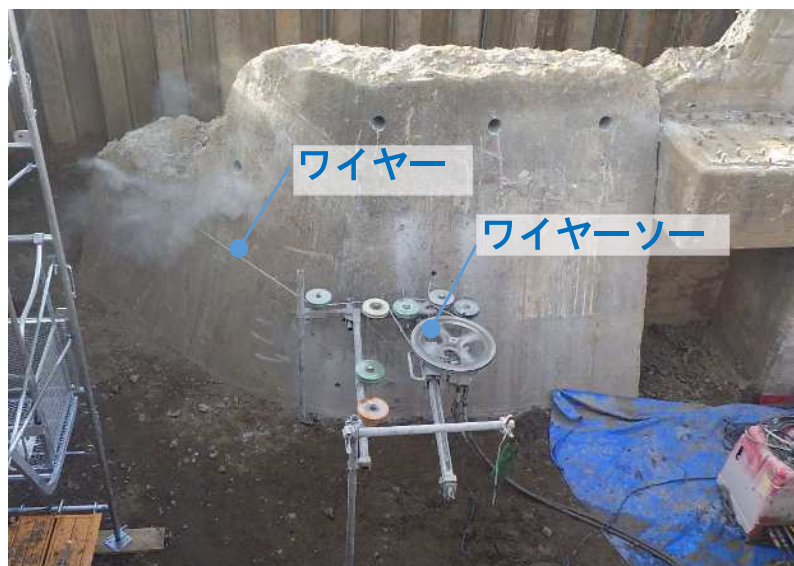
ワイヤーソーによる切断
