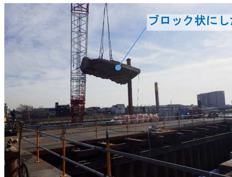
コンクリートの撤去
