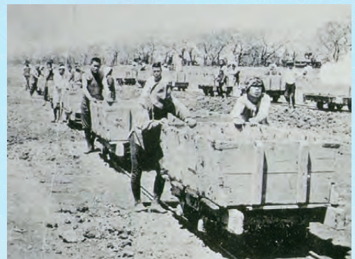
▲開削当初は機械が少なく、人力が頼りでした。掘った土はトロッコで堤防を造る場所まで運ばれました
