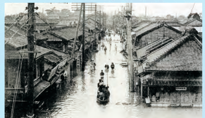
▲明治43年の大洪水の様子（足立区千住付近）。当時の荒川は蛇行した流れで、大雨のたびに大量の水があふれて洪水を引き起こす、まさに「荒ぶる川」でした
