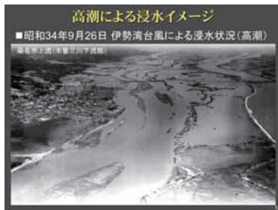
これは伊勢湾台風ですが、昭和34年のことです。愛知県で名古屋圏を中心に5千人の方が亡くなったような状況ですが、これをみていただくと一面水没という状況です。河川洪水と高潮の洪水は、少しイメージが違うのです。河川の洪水って堤防が切れるとそこから水が流れ出ます。水の供給源は川幅一杯です。堤防が切れたピンポイントから水が出始め拡散していくから、基本的に薄く入って徐々に水位が上がるというイメージをとるわけです。ところが高潮は、相手は海の水です。高潮ですから、海面が上がるわけです。それが流れ込んでくるとなると、無限の水を流し込んできますから、どれだけ堤防が切れてもそれで良しとしてくれない。普通の川の洪水であれば、右岸が切れれば、左岸は助かります。だってそこから水が出ていくと水位が下がりますから。だから、昔の話ですが、向こうが切れるところはバンザイとやったわけです。土嚢積み合戦をやったわ
