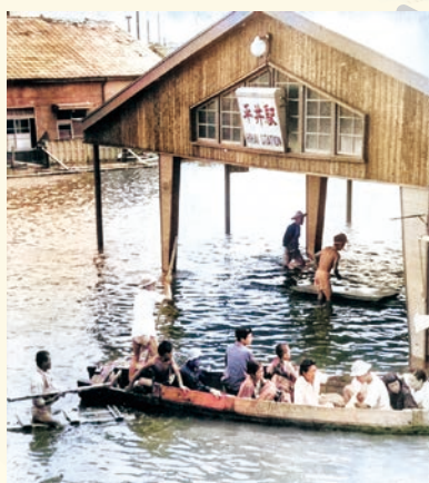
江戸川区の歴史は、水害との闘いの歴史でもあります。写真はキティ台風で水没した平井駅(昭和24年(1949年)9月1日撮影)。台風上陸が満潮と重なったために、平井など複数の地域で1万3000戸近くの住宅が浸水被害に遭いました。
