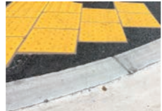
道路のバリアフリー化のために設置された「ゼロ段差擦り付けブロック」
