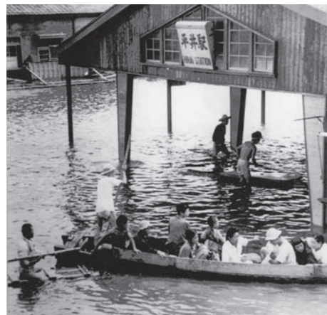
キティ台風により水没した平井駅前
