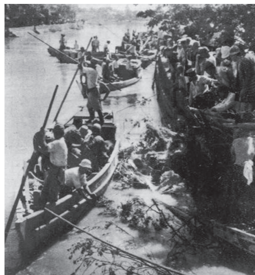
カスリーン台風により被害を受けた新川南岸の堤防を補強
