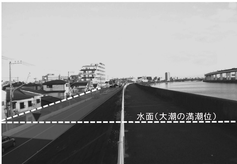
中川左岸堤防の状況
