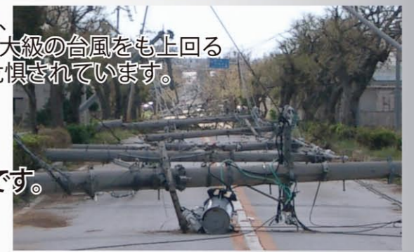
2003年台風14号の強風被害 (写真：宮古島地方気象台)
