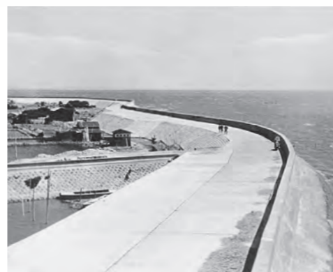
葛西海岸堤防
