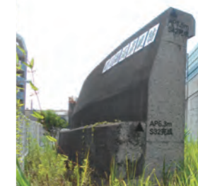
葛西海岸堤防跡。断面には当 時の堤防の高さと完成時期が 記されている
