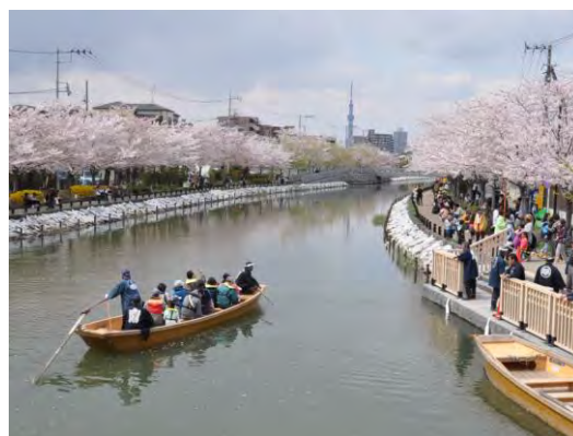
整備後の新川
