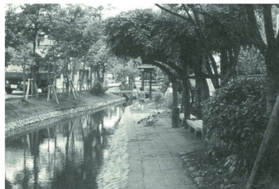
古川親水公園完成時（昭和48(1973)年7月）
