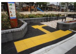
公園出入口視覚障害者誘導用ブロック
