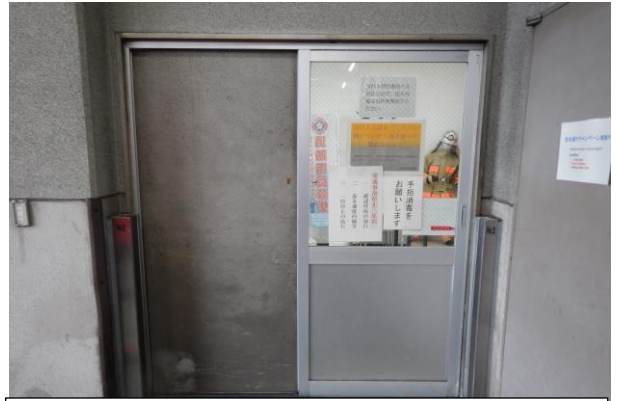
車庫から建物へ入る入口部分（通常）
