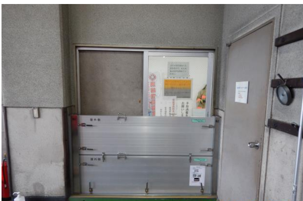
車庫から建物へ入る入口部分（止水板設定時）
