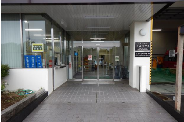
玄関部分の通常時の状態
