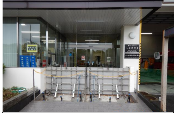
玄関部分の止水板を設定した状態（正面）
