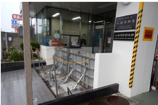
玄関部分の止水板を設定した状態（左側面）
