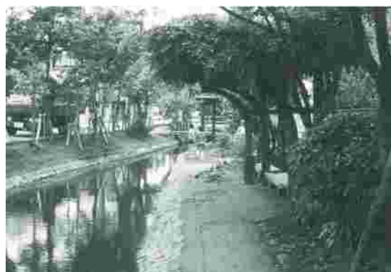
古川親水公園完成時（昭和48（1973）年7月）
