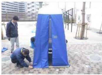
マンホールトイレ
