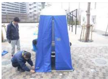
マンホールトイレ
