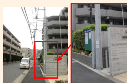
電柱の路外移設（東葛西二丁目）
