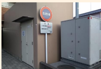
マンション (西小松川町)
