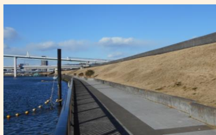
中川の堤防（耐震補強済み）
