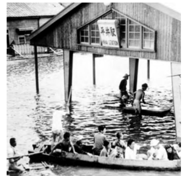
キティ台風による被害(平井駅)
