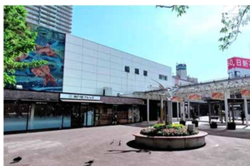
船堀駅および駅前広場
