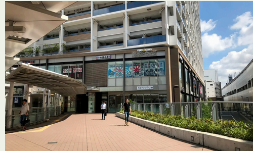
空間をつなぐペDESTリアンデッキの例（京急蒲田駅）
