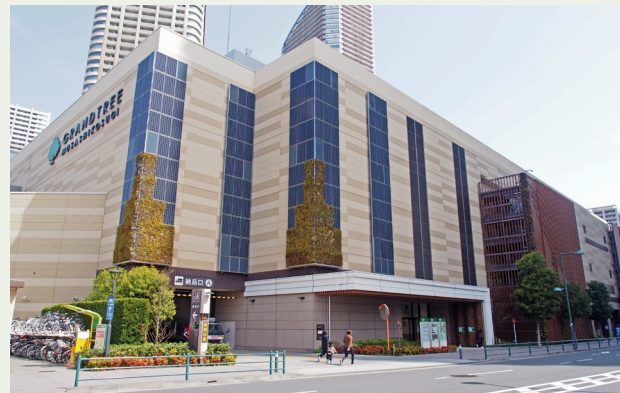
環境への配慮の例 壁面緑化と壁面のソーラーパネル（グランツリー武蔵小杉）
