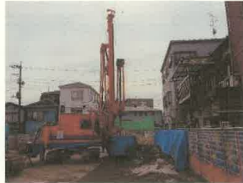
CI-CMC 工法施工状況
