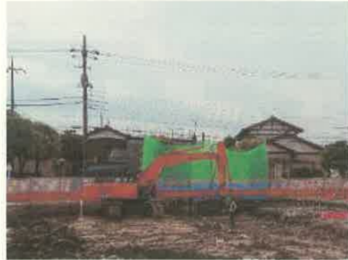
パワーブレンダー工法施工状況
