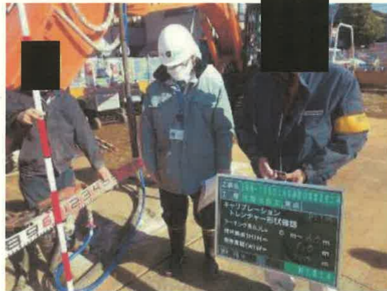
令和3年1月25日 地盤改良工 固結工 (パワーブレンダー工法) キャリブレーション トレンチャー形状確認 ●マーキング長L=0~6.0m 攪拌機長(H)H = 5.0m 攪拌翼幅(W)W = 1.0m
