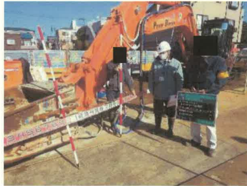
令和3年1月25日 地盤改良工 固結工 (パワーブレンダー工法) キャリブレーション トレンチャー形状確認 ●マーキング長L=0~6.0m 攪拌機長(H)H = 5.0m 攪拌翼幅(W)W = 1.0m
