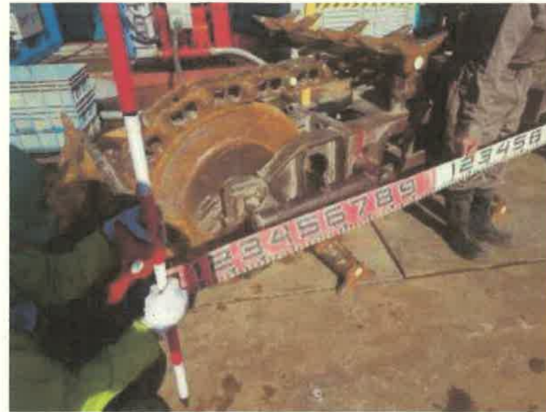
令和3年1月25日 地盤改良工 固結工 (パワーブレンダー工法) キャリブレーション トレンチャー形状確認 ●マーキング長L=0~6.0m 攪拌機長(H)H = 5.0m 攪拌翼幅(W)W = 1.0m
