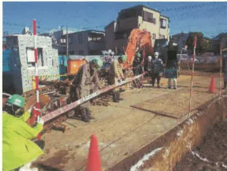
令和3年1月25日 地盤改良工 固結工 (パワーブレンダー工法) キャリブレーション トレンチャー形状確認 ●マーキング長L=0~6.0m 攪拌機長(H)H = 5.0m 攪拌翼幅(W)W = 1.0m
