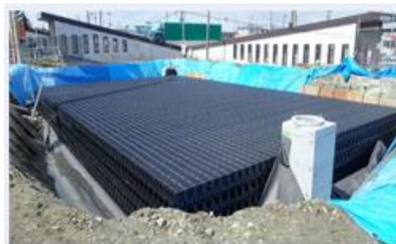
雨水貯留槽の設置
