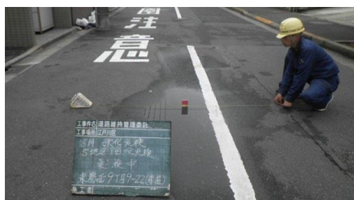
写真- 4.2 定期点検
