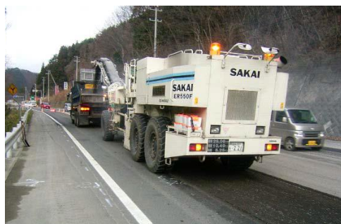
写真- 6. 2 切削オーバーレイ工法
