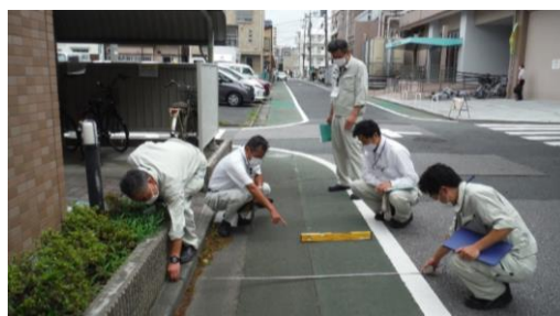
写真- 4.1 日常点検
