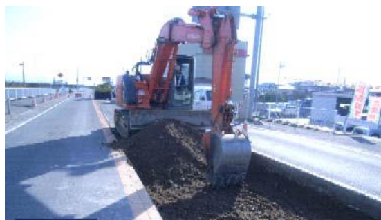
写真- 6. 3 路盤打換え工法
