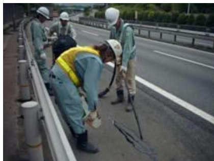
写真- 6. 1 シール材注入工法
