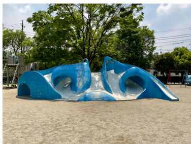
写真：老朽化した遊具（石山すべり台）
