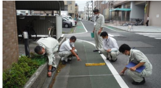
写真- 4.1 日常点検
