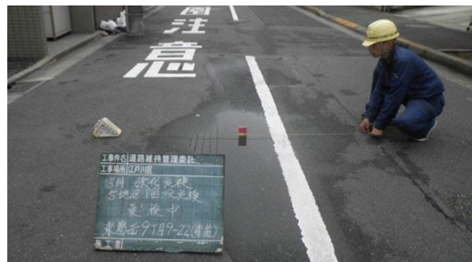
写真- 4.2 定期点検
