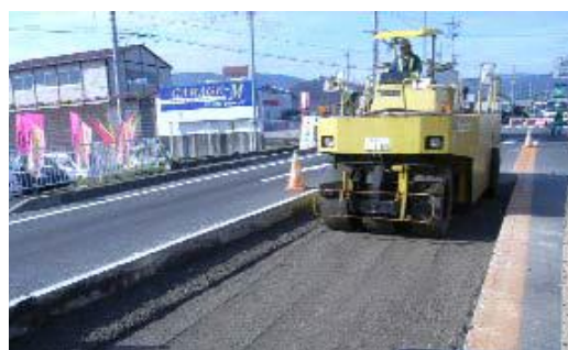
写真- 6.3 路盤打換え工法
