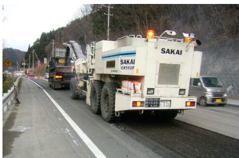
写真- 6.2 切削オーバーレイ工法
