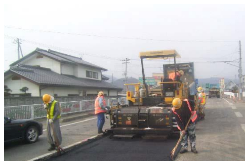
写真- 6.2 切削オーバーレイ工法
