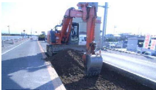
写真- 6.3 路盤打換え工法
