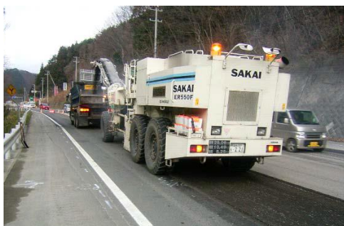
写真- 6.2 切削オーバーレイ工法
