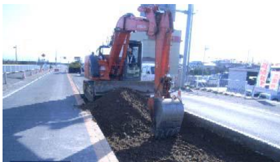
写真- 6.3 路盤打換え工法
