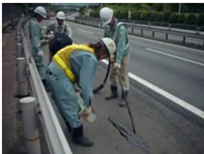
写真- 6.1 シール材注入工法
