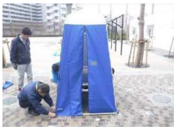
マンホールトイレ
