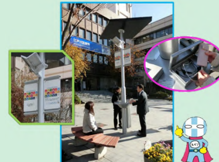
江戸川区役所本庁舎前 ソーラー充電スタンド
