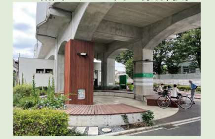
武蔵境駅から東小金井駅間の高架下
