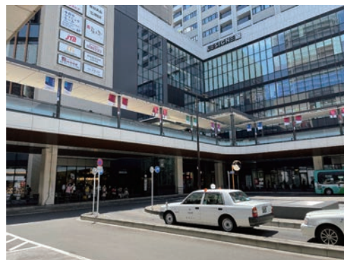
駅前の上部空間を活用した歩行者デッキ(府中駅)
