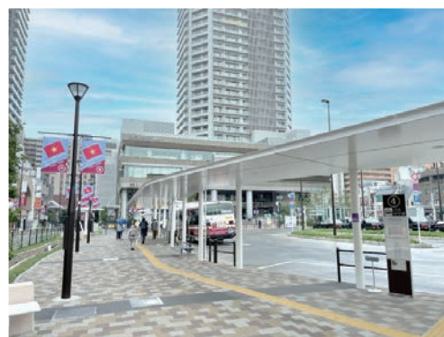
交通結節点となる駅前広場(国分寺駅北口駅前広場)
