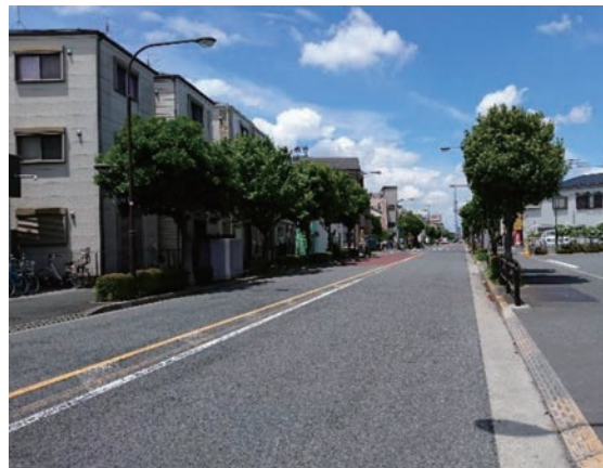
整備が完了した都市計画道路 (都市計画道路補助第286号線)
