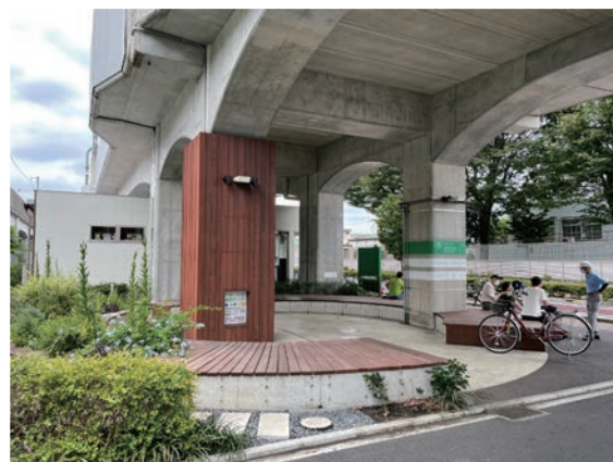
鉄道の立体化により創出される空間の活用 (武蔵境駅から東小金井駅間の高架下)
