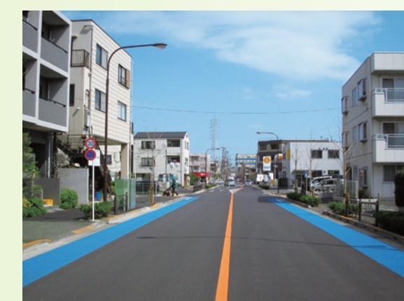
完成した補助第289号線（船堀五丁目）
