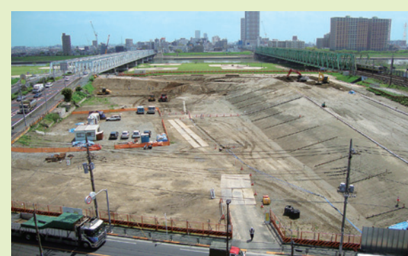
工事中のスーパー堤防（北小岩一丁目）
