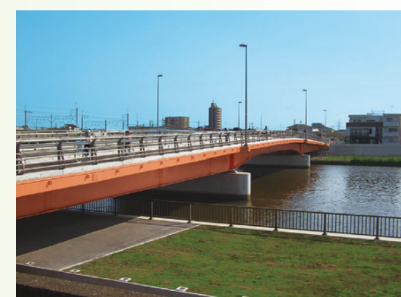
架け替えをした上一色中橋
