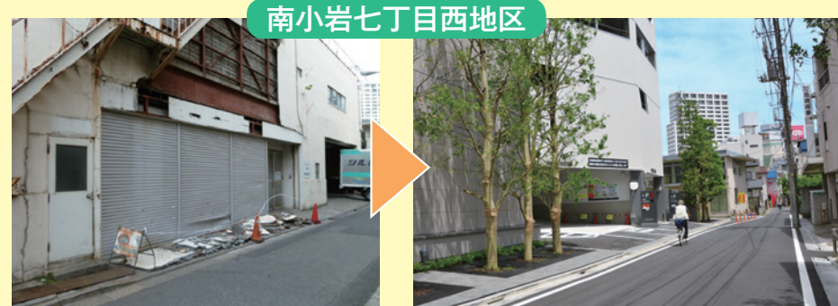
東日本大震災時に外壁落下
