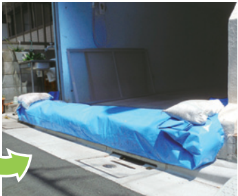
▲土のうの設置例
