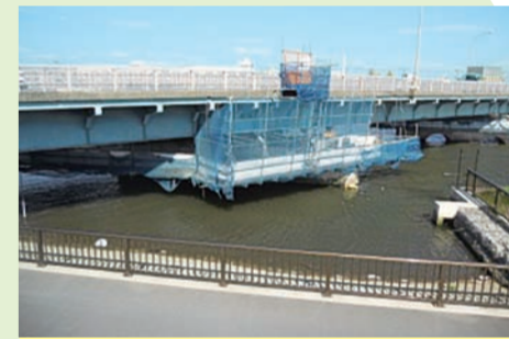
耐震補強工事中の瑞江大橋
