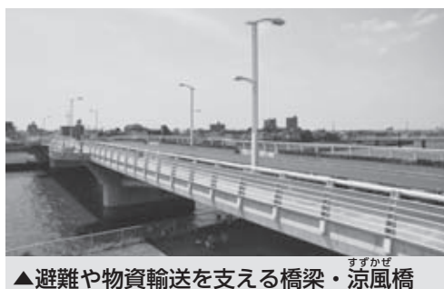
▲避難や物資輸送を支える橋梁・涼風橋
