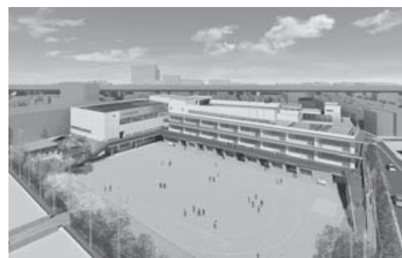
▲改築工事が始まった松江小学校（新校舎完成図）
