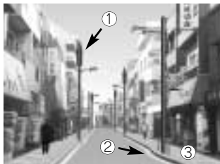
①街路灯の上に変圧器を設置。 ②車道を蛇行させて車のスピードを抑え、歩道が広くなった部分に街路灯を設置して歩行空間を確保しました。 ③景観を向上させ、維持補修しやすいブロック式のカラー舗装にしました。
