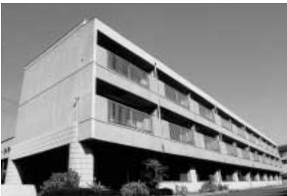
心身障害者複合施設に生まれ変わる旧常盤寮
