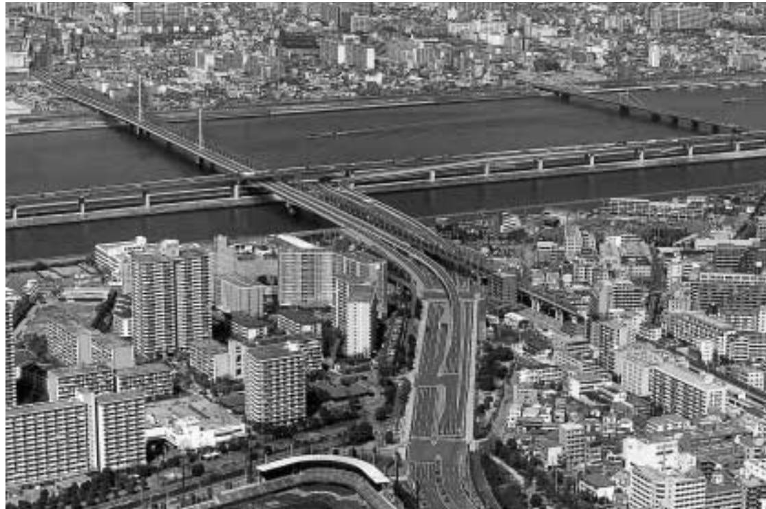
■荒川横断橋・清新町ランプ完成後のまちなみ
