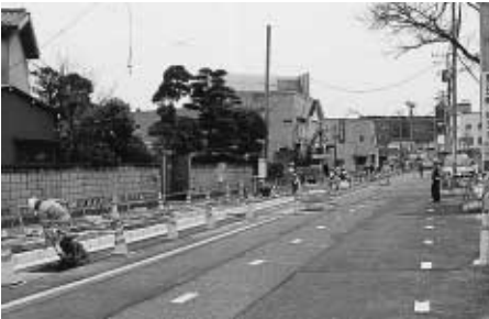
■着実に進む都市計画道路の整備
