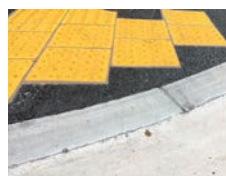
道路のバリアフリー化のために設置された「ゼロ段差擦り付けブロック」
