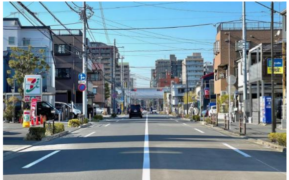
図 令和6年3月に開通した 都市計画道路補助第288号線（南篠崎）
