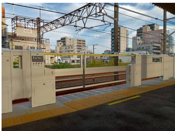
図 JR 総武線 平井駅のホームドア (令和7年10月31日 供用開始)
