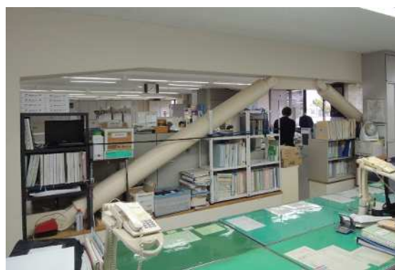
耐震補強の状況
