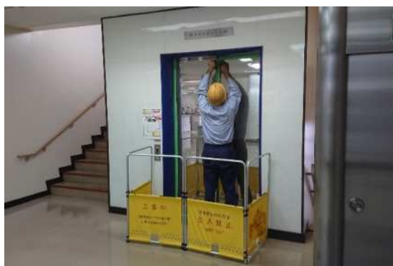
エレベーター改修工事
