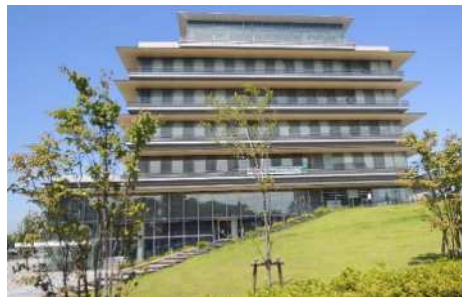
周辺環境に配慮した敷地内の緑化空間 (習志野市)
