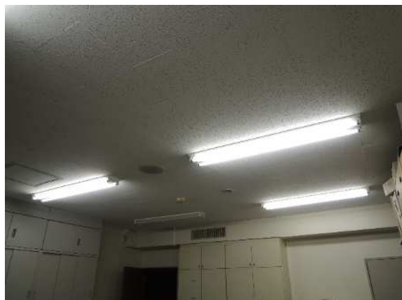
LED 化されていない照明
