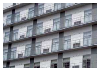
保全・更新に配慮したメンテナンスバルコニー (広島県三原市)
