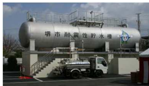
非常用給水設備（大阪府堺市）
