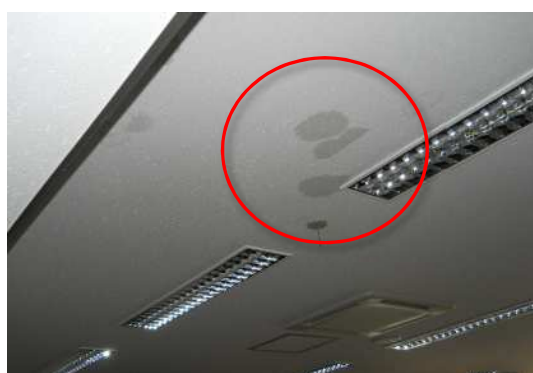
漏水による天井のシミ
