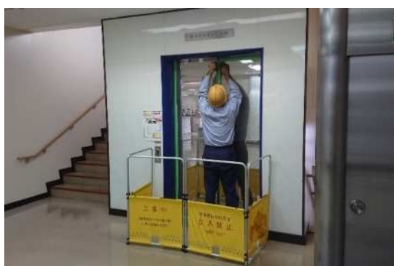
エレベーター改修工事
