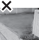
ステップでふさがれている雨水ます
